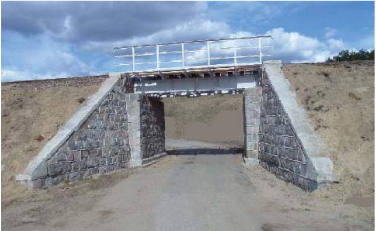
Rysunek 1. Kolejowy obiekt inżynierski
