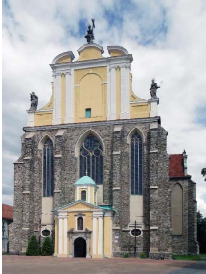
Kościół Wniebowzięcia Najświętszej Maryi Panny i św. Jakuba Starszego w Kamieńcu Ząbkowickim
